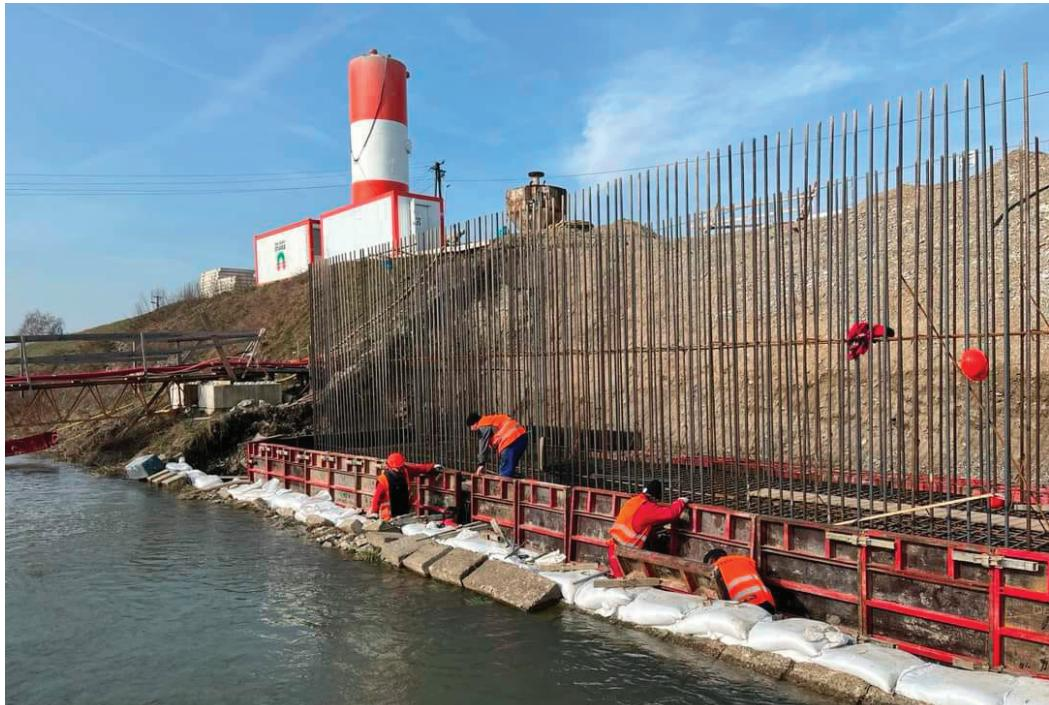
**betónových oporných pätiek a následnou prekládkou oceľovej konštrukcie na vybudované opory,**“ opísala postup prác L. Kukučková. Nasledovať bude montáž betónovej mostovky a chodníkov, montáž oceľových zábradlí a cestných zvodidiel. Zároveň bude potrebná prekládka inžinierskych sietí na novú mos-
