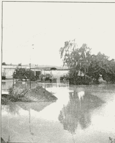
Spodná voda prekvapila i pracovníkov v objekte Okresnej správy ciest
