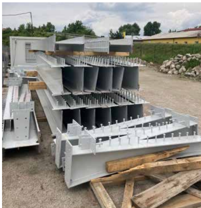
Prvé časti novej mostnej konštrukcie sú už v Ilave.
