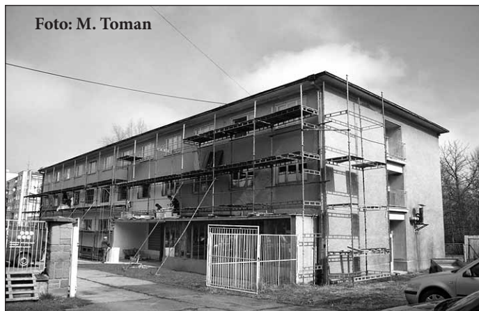
Rekonštrukčné práce a zatepľovanie fasády na niekdajšej „slobodárke“ uskutočňuje nový majiteľ.
