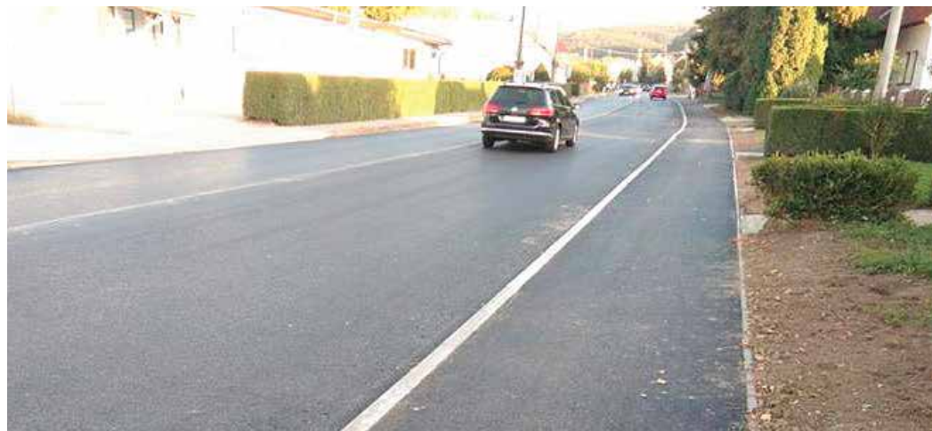
V minulom roku prebehla v meste už tretia etapa rekonštrukcie ciest a chodníkov. Do očí bijúca je Pivovarská ulica, ktorá kompletne zmenila svoj vzhľad. Posledný úsek jej chodníka by sa mal opraviť tento rok.
