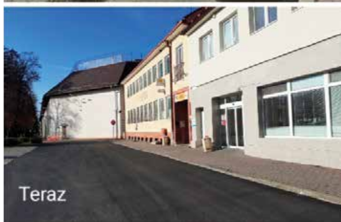
V druhej etape rekonštrukcie ciest a chodníkov bol nový asfaltový koberec položený aj na Mierové námestie.
